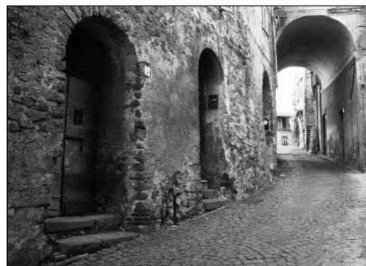
Opportunità per i proprietari di immobili del centro storico
